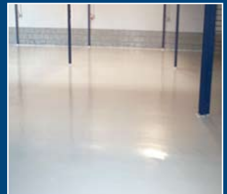
...en ten slotte het eindresultaat met een harde slijtvaste epoxy coating.
