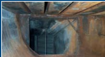
Het proces van reinigen, ontroesten, primerbehandeling en het eindresultaat met de chemisch bestendige toplaag.
