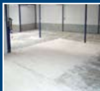
Aufbringen der Deckschicht und der Gießbeschichtung.
