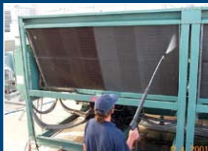
Der Kondensator wird vorbehandelt bevor der Beschichtungsprozess beginnt.
